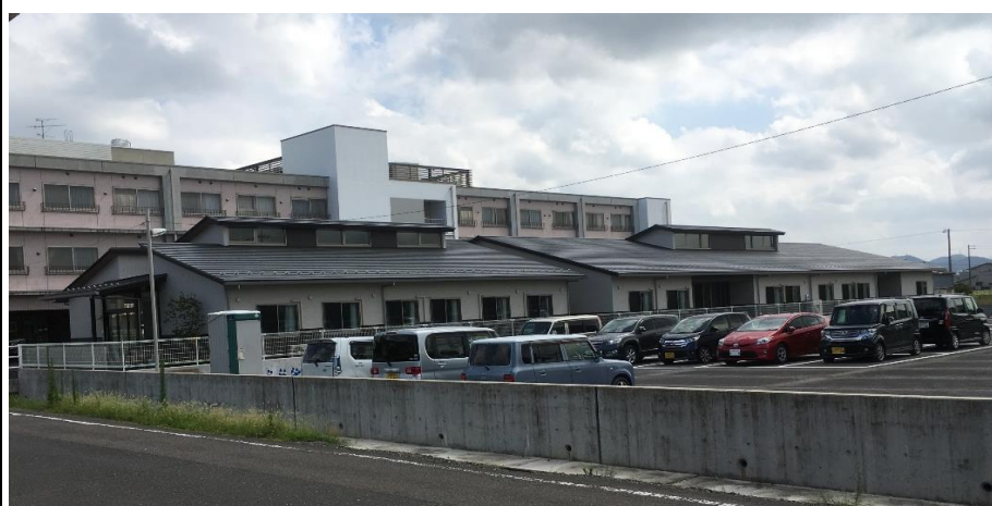
画像1 竣工時全景
